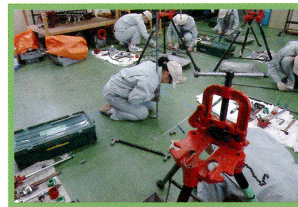
配管工事実習
